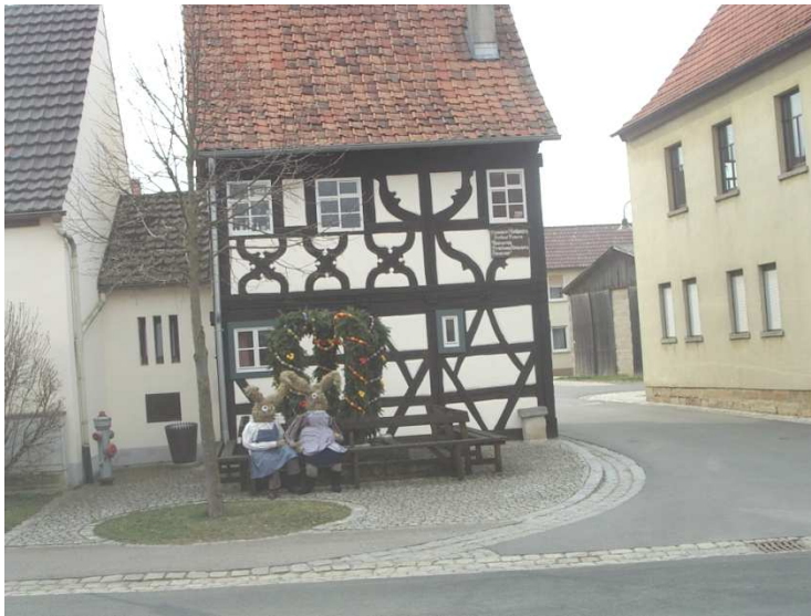
Sanierung Torhaus mit Jugendräumen
