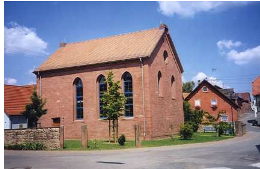
Erhalt und Umbau der ehemaligen Synagoge (Sängerheim)
